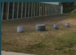
5 betonnen prikkels PSN
