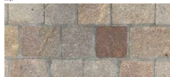
Verpavement en verblifgebied: egte graniet kleinformaten 22x11, 11x11 cm
