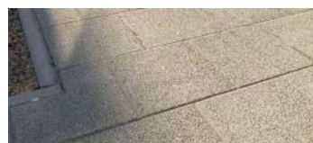
Verharding langs de nieuwe woonbebouwing: betonstraalstenen met een merwebbult toplaag 22x22x8(50)
